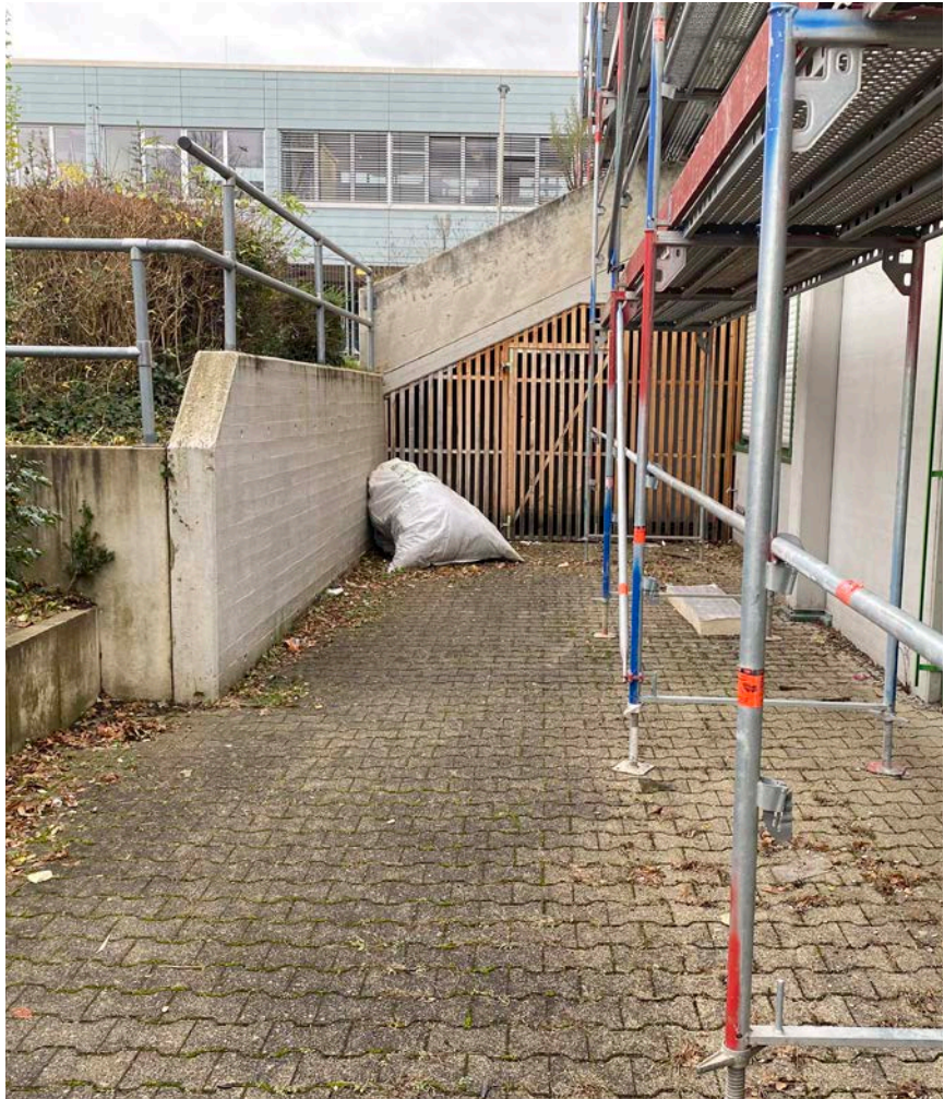
Holzverschlag und Betonmauer
