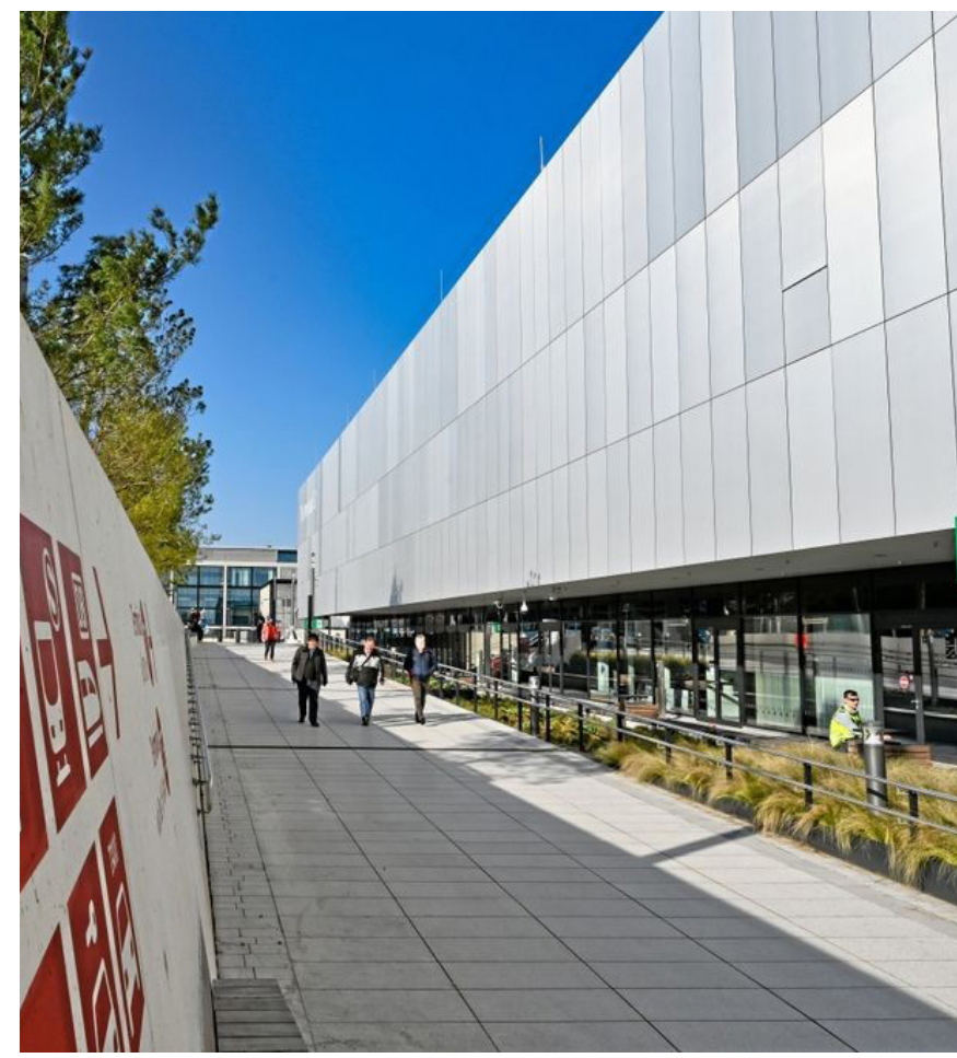
Rampenanlage mit Gräserpflanzung
