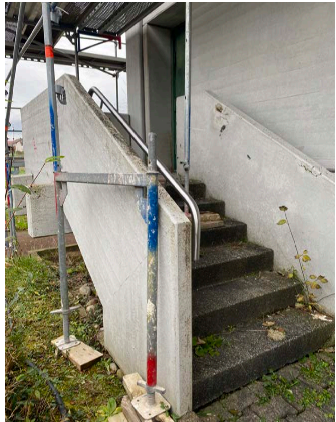
Treppe zum Eingang OG
